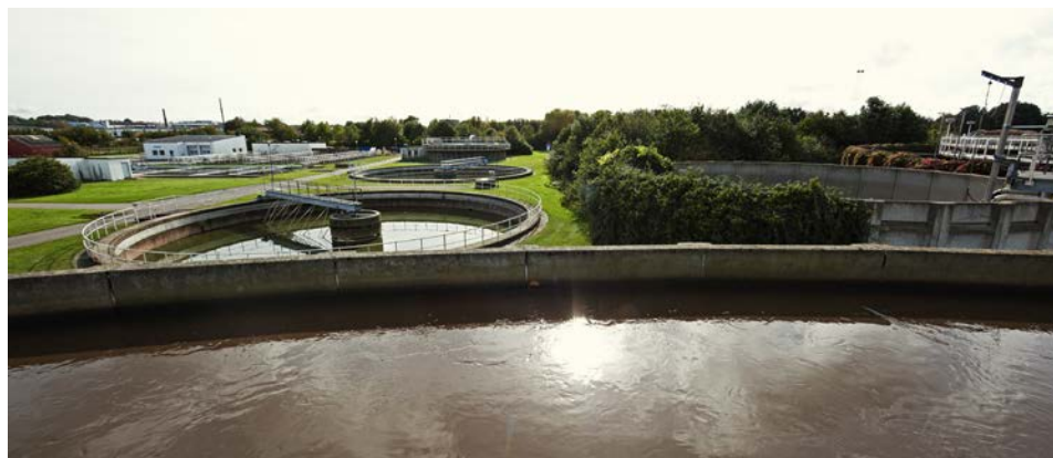
Under en period på fyra år ska det nya SCADA-systemet införas i hela verksamheten vid Vatten & Miljö i Väst AB (VIVAB). Över 50 procent av Sveriges invånare får vatten där Cactus övervakningssystem reglerar nivåerna. Foto: VIVAB | Cactus Utilities
